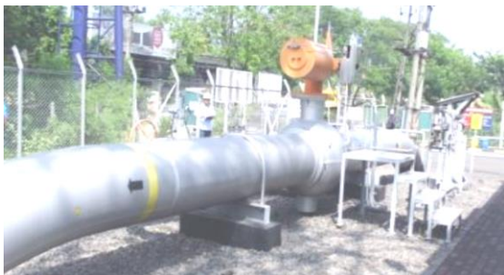
Gambar 1. Sistem katup pengaman pada pipa penyalur gas “PG-II” [8].
