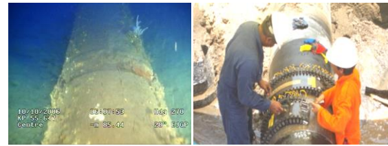
Gambar 5. (kiri) Pengamatan kondisi coating dengan ROV monitoring pada pipa offshore . (kanan) Instalasi dan persiapan inspeksi bellhole dan LRUT pada pipa penyalur "PG-I" di lokasi landfall pipa offshore [8].
