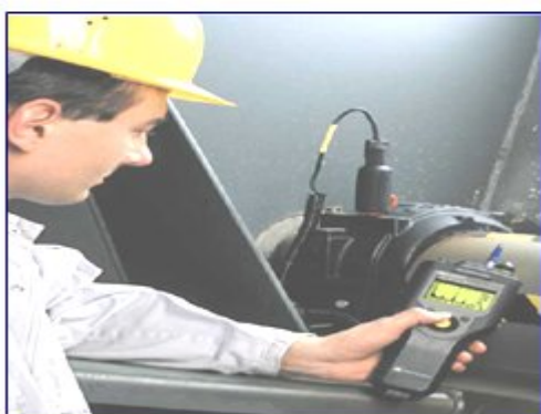
Gambar 16 : Cara pengukuran vibrasi pada pompa
