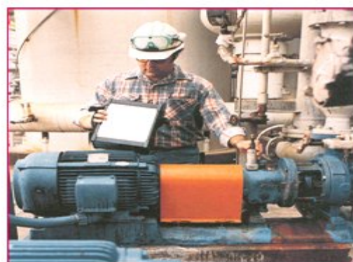
Gambar 16 : Cara pengukuran vibrasi pada pompa
