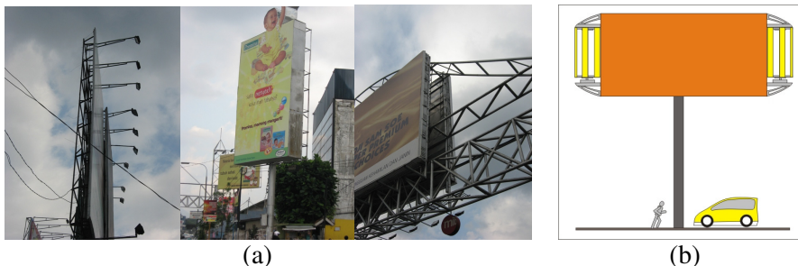
Gambar 6 (a). Bermacam jenis konstruksi billboard , (b) Posisi dan ukuran turbin terhadap billboard .
